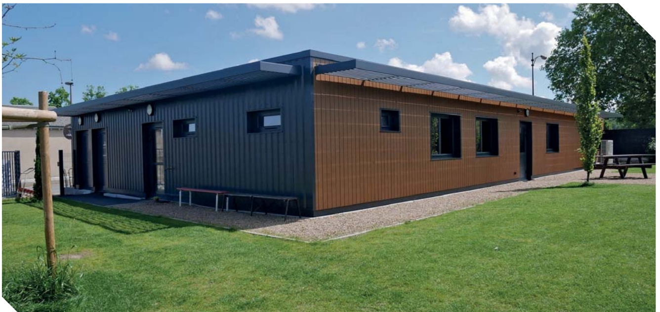
En 2023, un nouveau bâtiment a été créé pour la direction des Espaces verts. Il s'inscrit dans la démarche environnementale RE 2020 et est équipé d'une pompe à chaleur.
